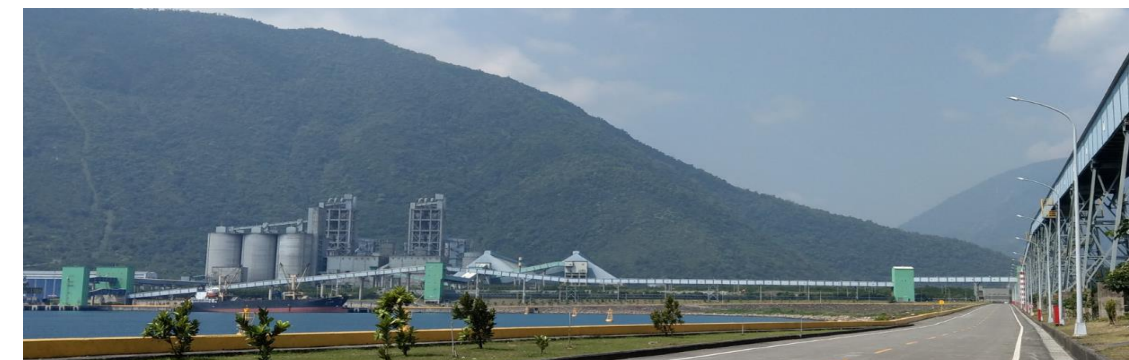
運煤船直接透過密閉式輸送管道，送往發電廠與水泥廠使用，以降低揚塵。
